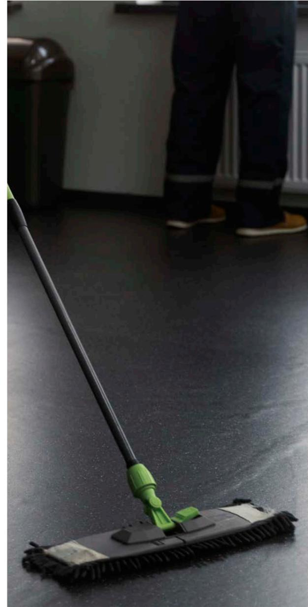
Após a colocação do material, é essencial realizar uma limpeza completa. Se os resíduos de rejunte não forem eliminados corretamente ou rapidamente, podem surgir manchas difíceis de remover e formar uma película de concreto que retém todo tipo de sujeira.
