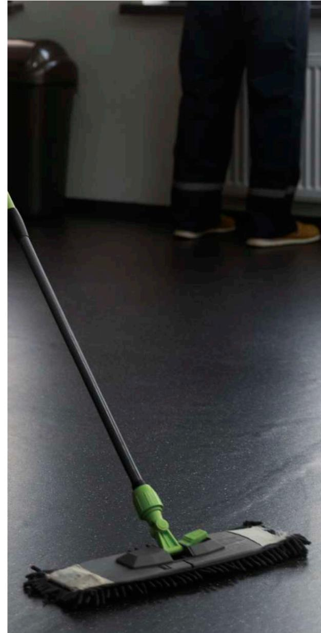
Después de colocar el material es esencial limpiarlos a fondo. Si los restos de lechada no se eliminan correctamente o con rapidez, pueden producirse manchas difíciles de eliminar y pueden crear una película de hormigón que atrapa todo tipo de suciedad.
